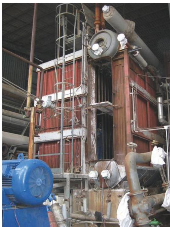
Réhabilitation totale d'une chaudière à tubes d'eau 50 t/h à 70 bars
