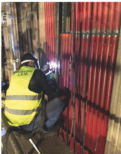
Remplacement d'un écran chaudière de centrale thermique au Maroc
