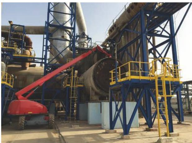
Fabrication et remplacement d'une chaudière de récupération de 120 t pour l'OCP au Maroc
