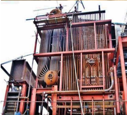
Montage & mise en service Chaudière FML
