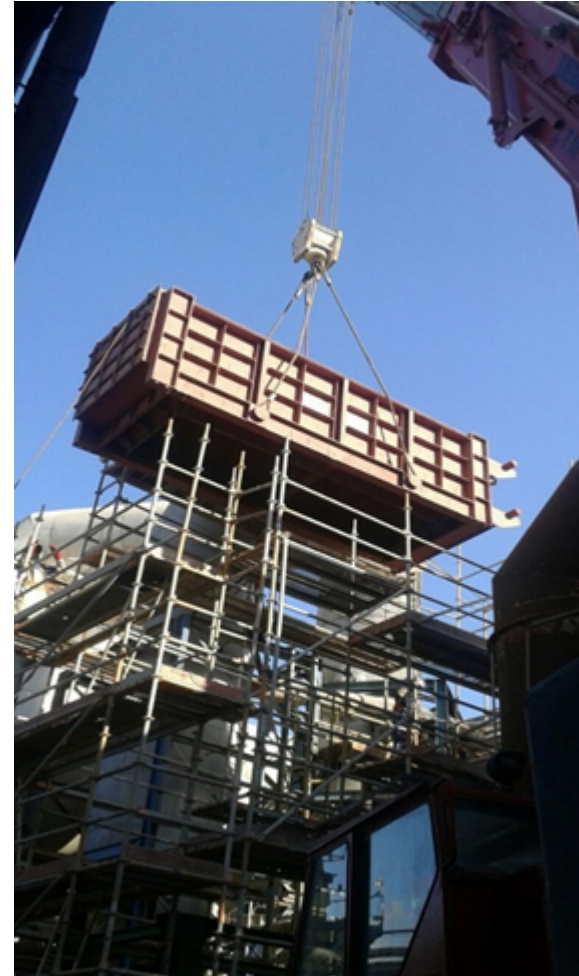
Fabrication & remplacement Chaudière de récupération 120T OCP
